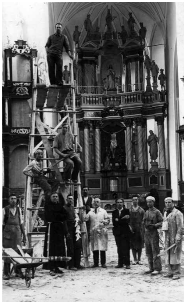
Remontuojant Kretingos bažnyčią. Viduryje baltu chalatu – Juozas Gedgaudas. 1937. Gedgaudų šeimos archyvas
